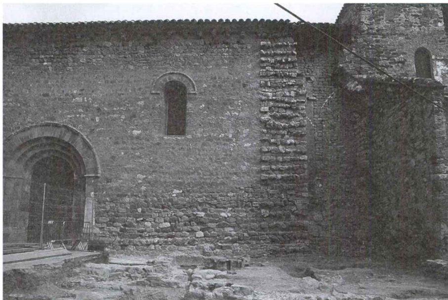
FIGURA 12. Façana de Sant Pere vista des del sud, on apreciem la unió entre la capçalera de Sant Pere Antic i la nau romànica.
