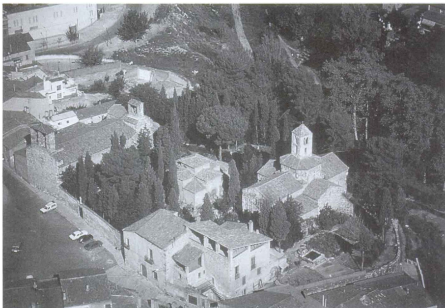
FIGURA 1. Vista general del conjunt monumental.
